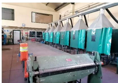
Taller de soldadura
